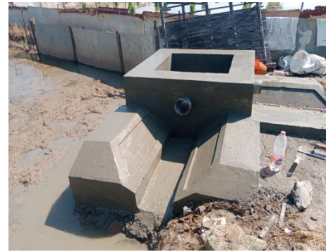
Gambar 2. Box jaringan irigasi air tanah
