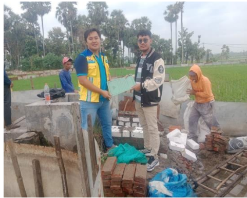
Gambar 1. Proses pelaksanaan Pembangunan sistem irigasi air tanah
