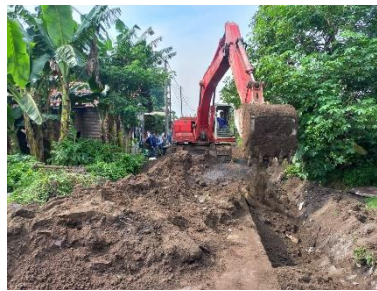
Gambar 1. Excavator berkerja di medan lumpur
