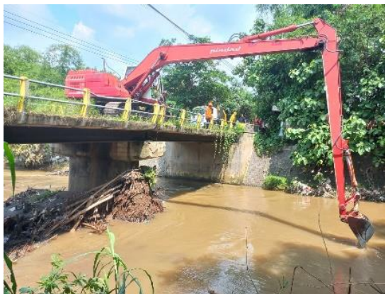
Gambar 2. Gambar excavator sedang mengambil sedimen
