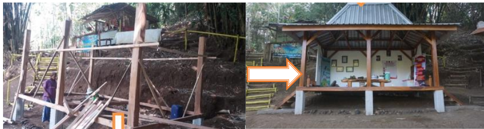
Gambar 5. Proses pembuatan gazebo dan hasilnya (Sumber: Dokumentasi pribadi)
