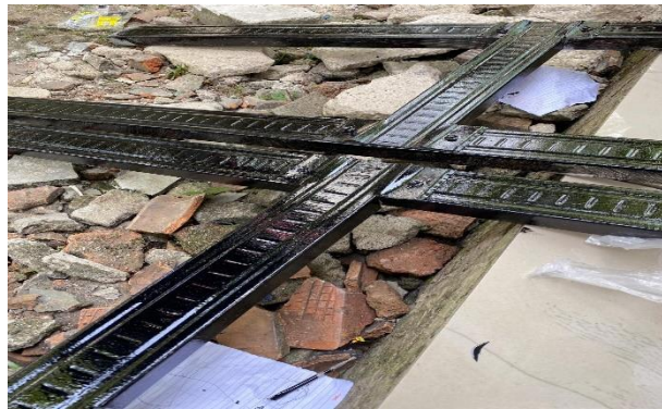
Gambar 2. Proses pengecatan baja ringan
