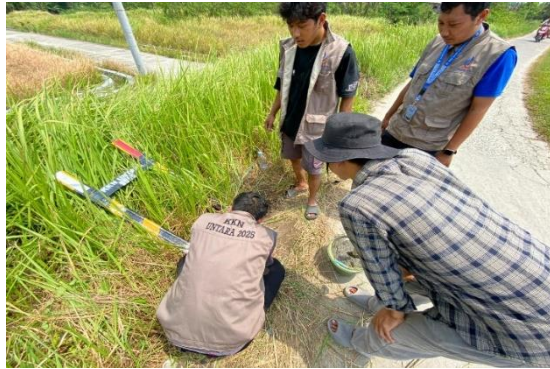
Gambar 3. Proses pemasangan reflector
