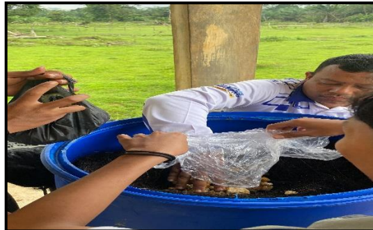
Gambar 6. Pemasangan Media Filter air (Ijuk dan Kerikil) sanitasi sekolah
