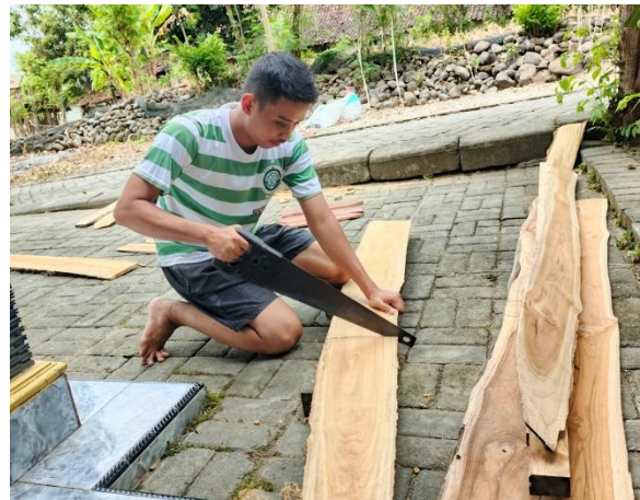
Gambar. 5 Pemotongan papan
