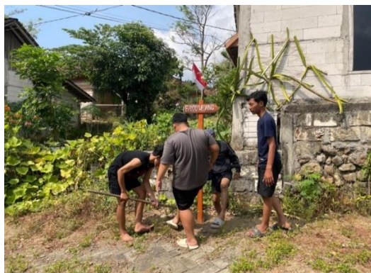
Gambar 9. Pemasangan papan petunjuk lokasi geosite
