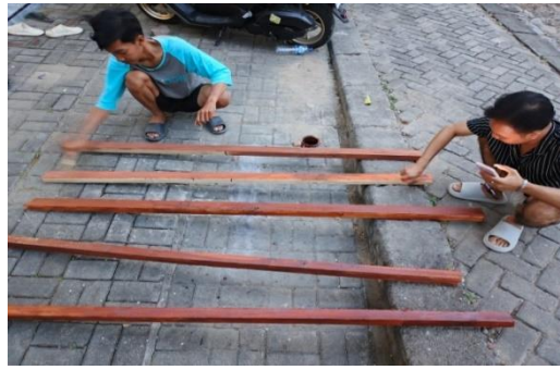
Gambar. 7 Pengecatan kayu dengan Plitur
